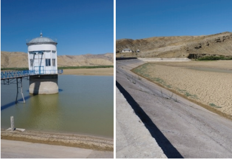
Şəkil 24. Pirsaatçay su anbarında lillənmə prosesinin təsviri.
